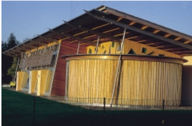
Holz ist ein zukunftssträchtiges Baumaterial. Auch moderne Architekturentwürfe lassen sich in Holz verwirklichen. Kindergarten in Bad Neuenahr, Stadtteil Ramersbach.
